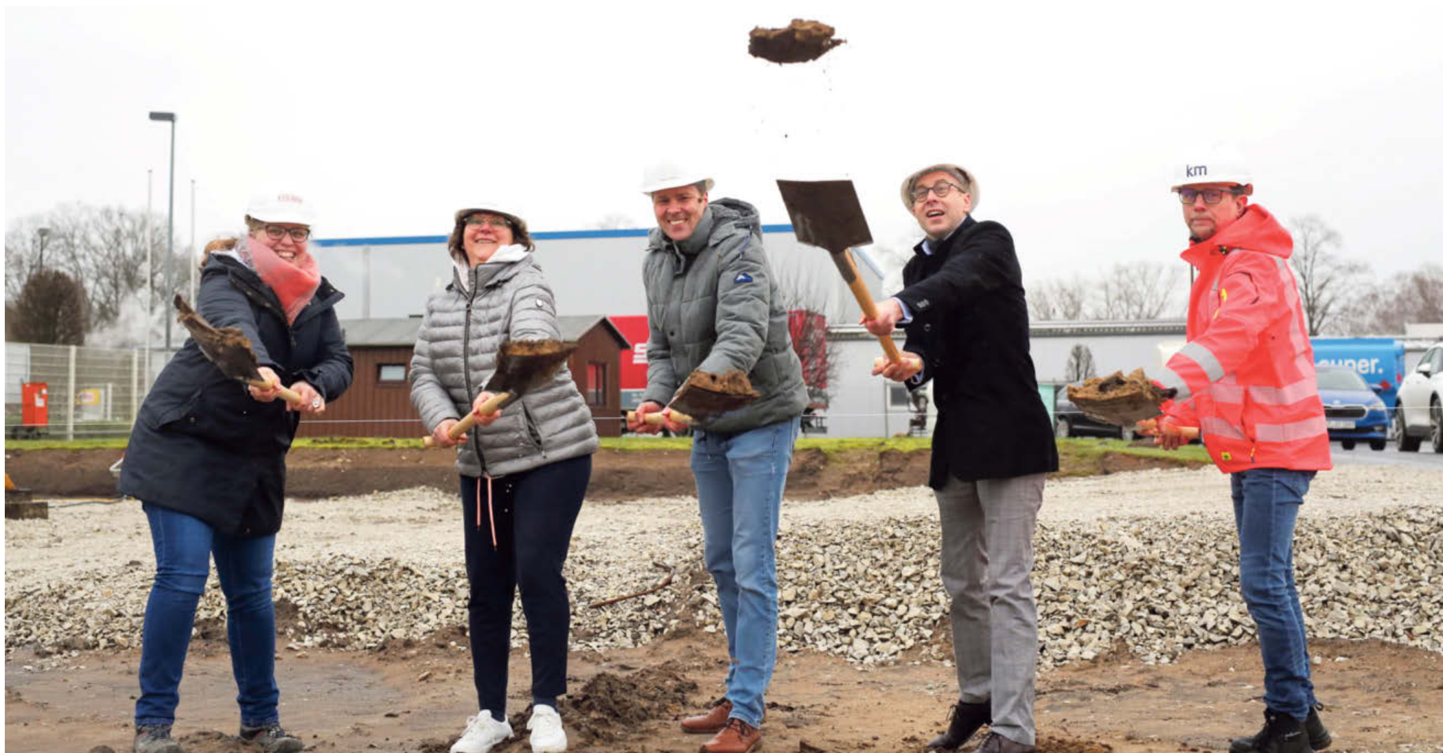
Der symbolische erste Spatenstich ist gesetzt. Stephanie Oberschelp (F+G-Bau), Inhaberin Heike Schrewe, Stefan Temme, Mitinhaber Hendrik Fip und Architekt Mirko Moch hoffen, dass die Büroräume und Lagerflächen noch in diesem Jahr bezogen werden können.
