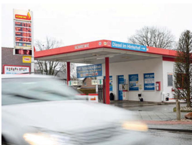
Die SB-Tankstelle an der Münsterstraße bleibt trotz der Erweiterung im Gewerbegebiet weiterhin bestehen.
